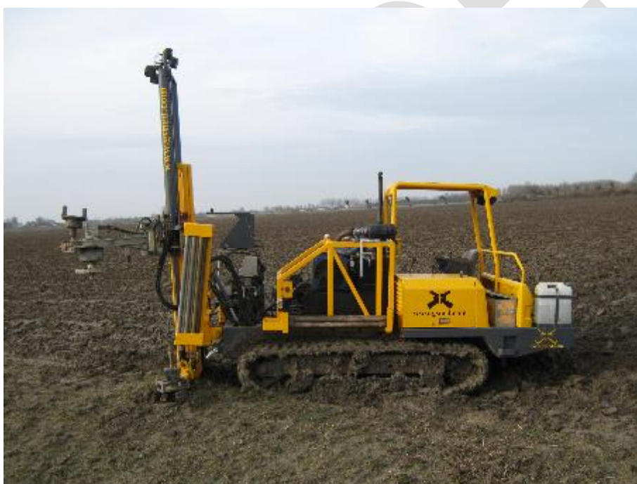
Figuur 3.1. EC-sondering Waterdunen. Foto: Bouw- en Management Service b.v.
