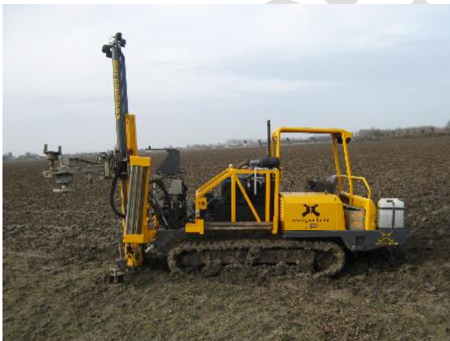
Figuur 3.1. EC-sondering Waterdunen. Foto: Bouw- en Management Service b.v.
