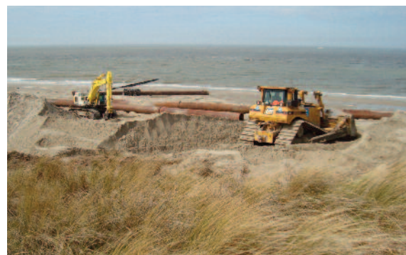
Dijkversterking door aanleg nieuw duin
